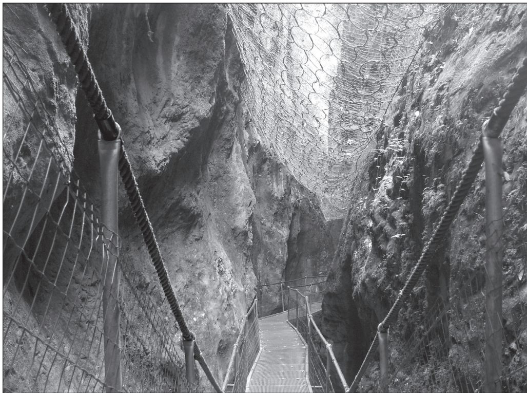
ILLUSTRATION 7 : Un aménagement lourd de l'espace (escalier, passerelle, filet-auvent métallique) (photo : André Suchet).
