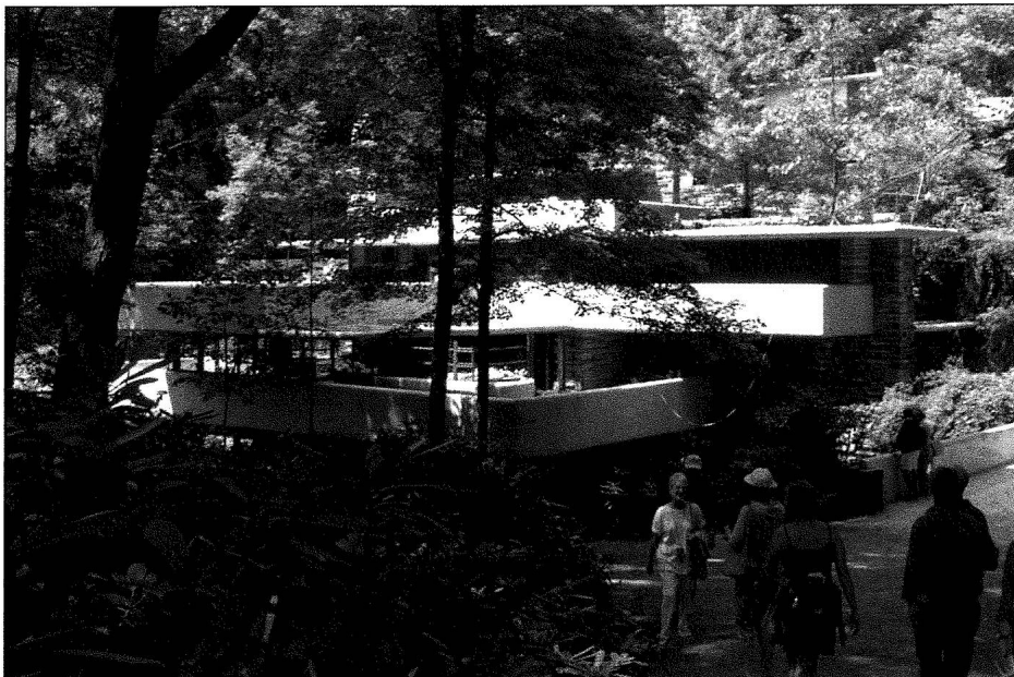
Fallingwater. Vue d'ensemble. Photo : Hassoun Karam.
