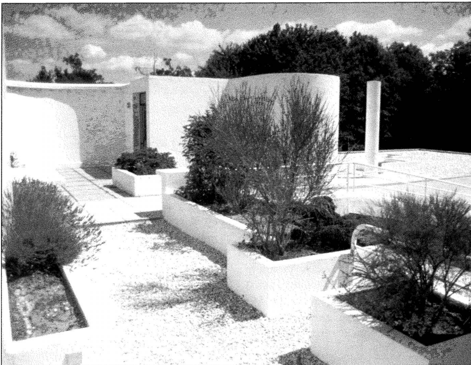
Villa Savoye. La terrasse sur le toit. Photo : Gabriel Rioux.
