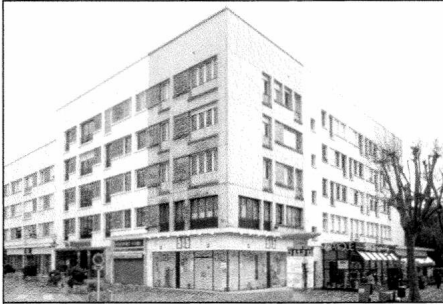
L'un des derniers immeubles non restaurés, témoin de l'état antérieur du bâti. Photo : P. Dieudonné.
