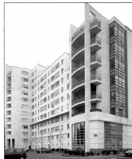
Quai de Rohan, opération de réhabilitation d'un grand ensemble de logements. L'immeuble a été coupé en deux parties pour laisser place à une rue, et sa façade a reçu de nouveaux éléments de confort (balcons, bow-windows, etc.). Photo : P. Dieudonné.
