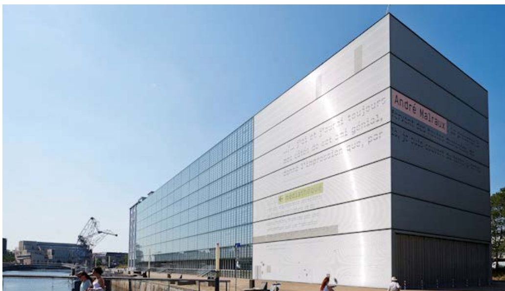
FIGURE 1 – Vue de la Médiathèque André Malraux de Strasbourg
