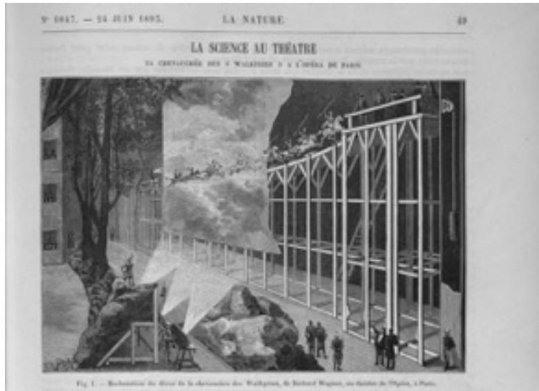
Figure 8 : *Le dispositif technique pour la chevauchée des Walkyries*, l'Opéra de Paris, 1893.
