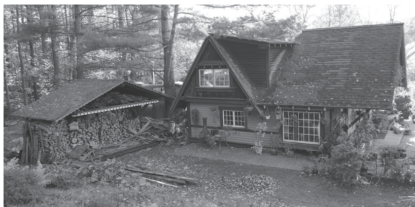
Vue de côté du chalet et remise à bois de chauffage construits par Henri Vaillancourt
