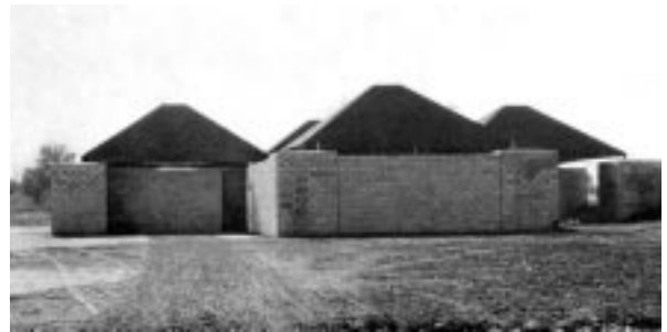
Planche 1. Petit édifice desservant une piscine (Louis Kahn, 1955).
