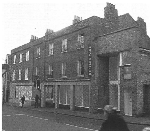
ILL. 5 Vue de la façade victorienne rue Castle pour Kettle's Yard par la firme d'architectes Jamie Fobert de Londres.
