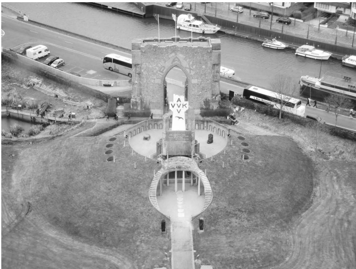
Image 3 : Crypte à ciel ouvert vue du dernier étage de la Tour. Avant d'être victime d'un attentat, la première Tour s'élevait au-dessus de la crypte.
