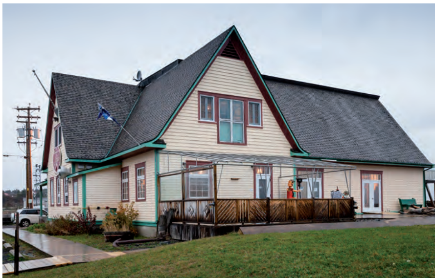
Des citoyens attachés à l'ancien entrepôt frigorifique de L'Anse-au-Griffon l'ont sauvé de la démolition et transformé en centre culturel. On le voit ici avant (en haut) et après sa restauration.
