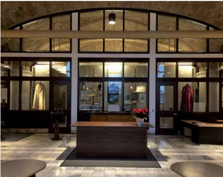
Un espace a été inséré à l'intérieur de la chapelle Pauline : un cube vitré sous atmosphère contrôlée. C'est là qu'on entrepose toutes les archives. Les vitrines permettent d'exposer des artéfacts.
