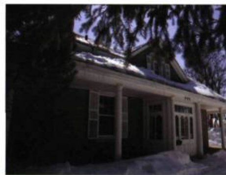
Le portique de la maison John-Snow, érigée en 1850, est une invitation chaleureuse à la découverte du chemin d'Aylmer.
