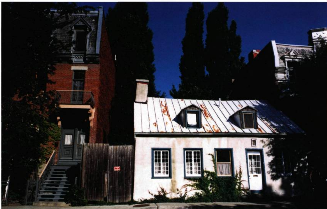
Deux maisons de la rue Saint-Louis, à Montréal, témoignent du contraste entre le logement urbain d'avant 1850 et celui d'après 1880.
