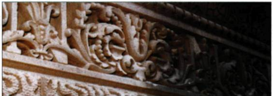
Détail de sculpture nettoyée par moitié selon le procédé de gommage® Thomann-Harry®; l'architecture est préservée. Photo : Michel Calmon
