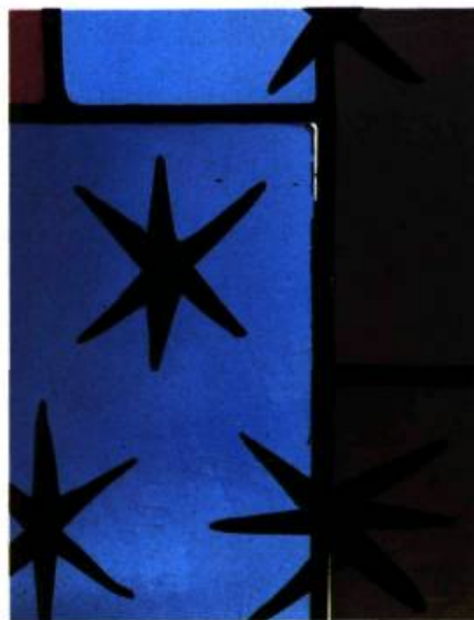
Le jour entre les plombs et les verres est la conséquence d'un mauvais travail d'assemblage. (photo: Jean-Guy Kérouac)
