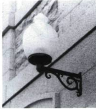
Luminaire électrique d'origine datant probablement des débuts de l'électricité. L'ampoule est protégée d'un globe de verre texturé auquel on a donné une forme décorative. (photo: François Varin)
