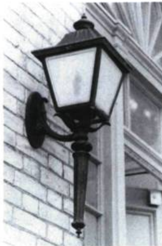
Cette lanterne reprend les lignes d'un luminaire au gaz. L'ouverture à la base servait à l'entrée d'air. Le fait que la partie supérieure soit fermée indique qu'elle a probablement été conçue dès l'origine comme luminaire électrique. (photo: François Varin)
