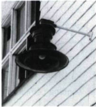
Appareil d'éclairage que l'on retrouvait fréquemment sur les bâtiments industriels, les entrepôts ou les ateliers. Ce modèle date du début du siècle et orne la façade de l'entrepôt de la compagnie Robin, à Bonaventure. L'édifice recyclé l'a conservé. (photo: François Varin)
