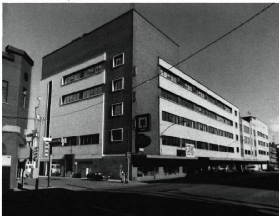
L'ancien magasin Pollack, construit en 1950, intègre deux bâtiments plus anciens. (photo: B. Ostiguy)
