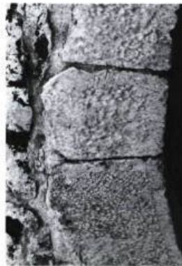
9 Pierres de taille aux arêtes relevées au ciseau et piquées à la petite pointe dans leurs faces. Ces pierres forment le cintre d'une des portes d'entrée de la poterne Dauphine des fortifications de Québec réalisée vers 1745.
