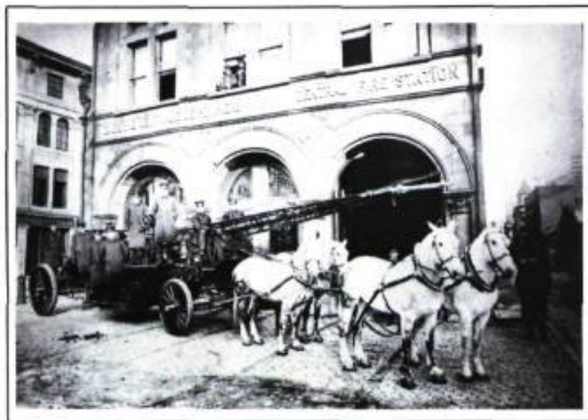
L'ancien poste de pompiers n° 13, située sur la rue Marie-Rollet à Québec et, à gauche, la caserne d'Youville (Montréal), photographiée au début du siècle.
