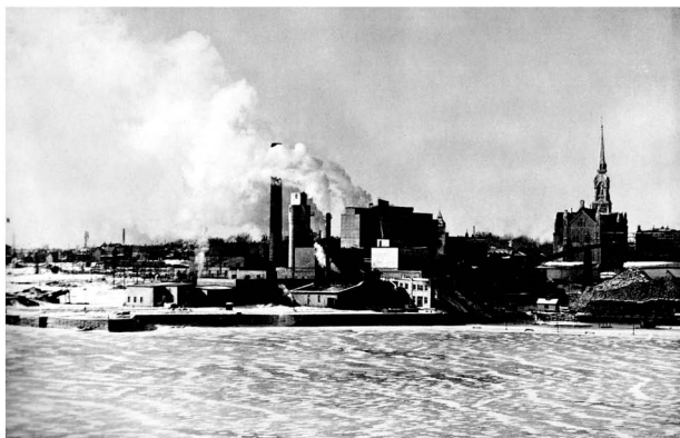
Figure 7 Vue sur le Parlement et les usines
