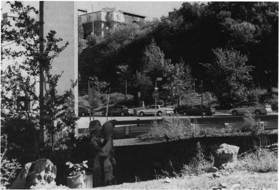
Photo 1 L'îlot Fleury sous l'autoroute en viaduc
