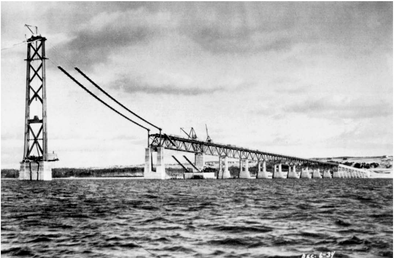
Construction du pont de l'île d'Orléans en 1933-1934. (Archives du ministère des Transports du Québec).
