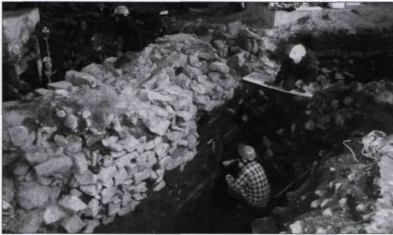
Les travaux d'aménagement du centre Ex Machina à l'intérieur de la caserne Dalhousie ont mis au jour les premiers quais construits au début du Régime anglais. (Photo : Ville de Québec).
