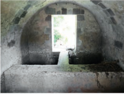
Réservoirs et couverture voûtée du bâtiment
