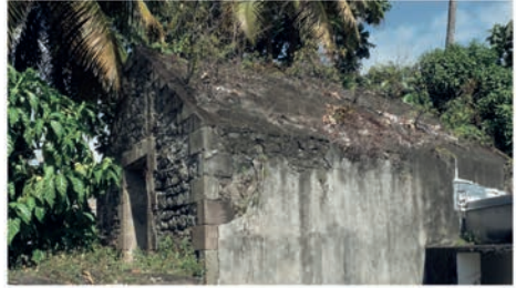
Bâtiment accueillant les réservoirs
