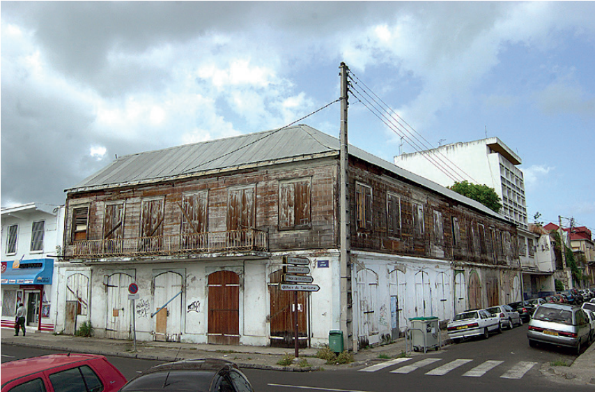
Illus. 4 : Ancien entrepôt, angle rue Peynier et quai Lefebvre : vue d'ensemble et détail d'architecture, Phot. inventaire, 200.
