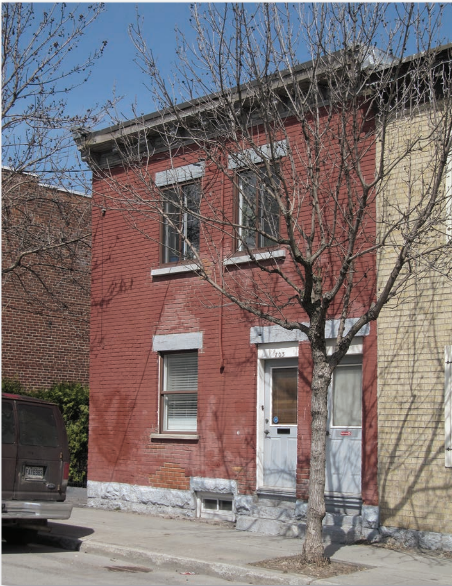
La maison Mullins-Tolan, construite en 1884, rue Charon. Jusqu'en 1893, les Mullins occupent un des deux logements et mettent l'autre en location. Ensuite, ils occupent toute la maison. À gauche, il n'y a toujours eu qu'une maison en fond de lot.
