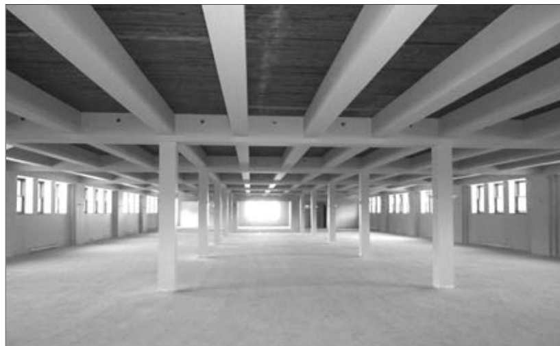
On peut notamment se réjouir de la conservation d'éléments architecturaux intéressants, tels les plafonds de bois du premier étage datant des années 1960.
