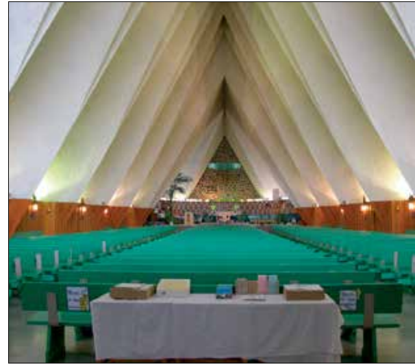
Imaginez quel défi ce fut de réaliser le toit plissé de l'église de Saint-Marc, dans l'arrondissement de La Baie, à Saguenay !
