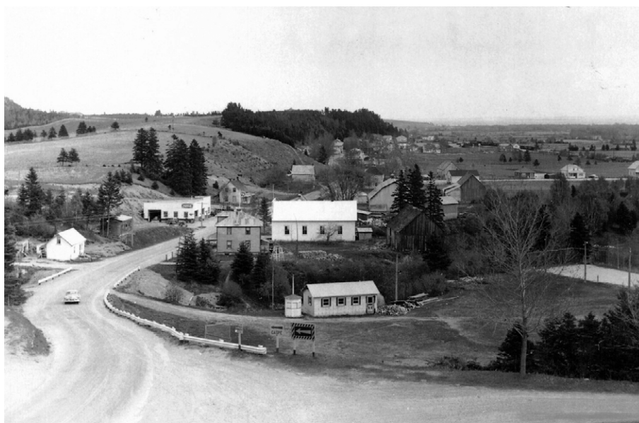
Au milieu du XX e siècle, Nouvelle est un village dont une bonne partie de la population travaille dans le secteur forestier et où on trouve de plus en plus d'infrastructures communautaires. On voit sur cette photo, au premier plan, la cabane de la patinoire jouxtée d'un petit kiosque qui servait au baseball pendant la saison estivale. (Vue au pied de la côte de l'église de Nouvelle, juin 1959. (Coll. Roger Bélanger).
