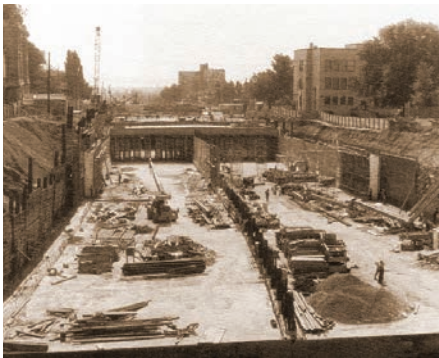
Autoroute Décarie, 1966. Au moment de sa construction, c'est la première route « en dépression » au Québec et la plus importante de ce genre au Canada. (Archives du ministère des Transports du Québec).
