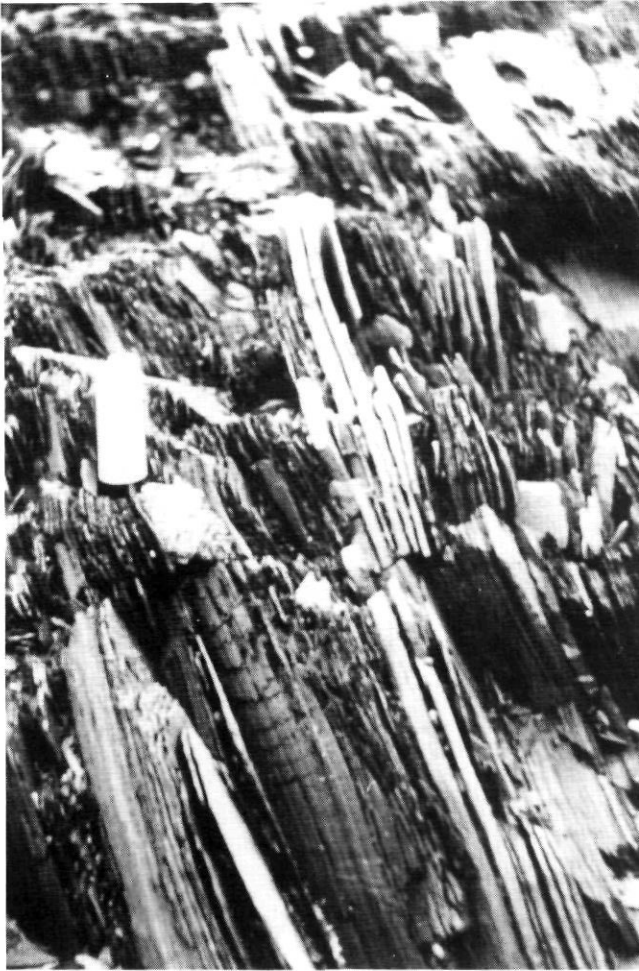
FIGURE 20. Feuilletés schisteux gonflés et en voie d'émiettement sur la plate-forme de la pointe du Bout d'en Bas. Le processus est vraisemblablement lié aux alternances d'humidification et d'assèchement (septembre 1980). Le briquet mesure 8 cm de long.
