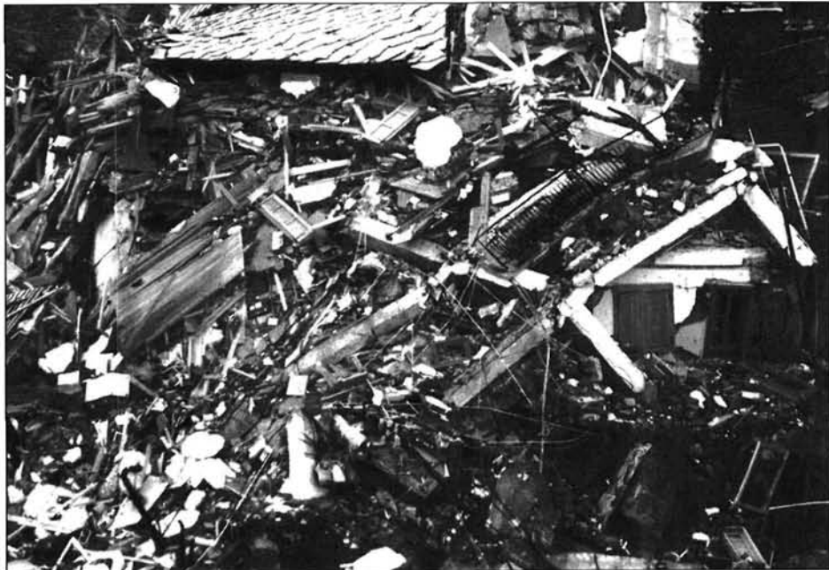
Figure 8 Glissement d'une maison dans la vallée de Cogne (octobre 2000)
