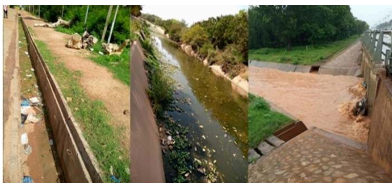
Photo 2. Vues partielles des canaux d'évacuation des eaux pluviales à Ouagadougou
