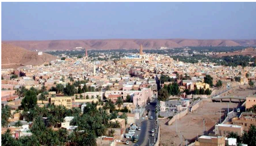
Figure 6. Vue générale sur la ville de Ghardaïa (en regardant vers l'ouest). L'oued M'zab apparait en bas à gauche de l'image.
