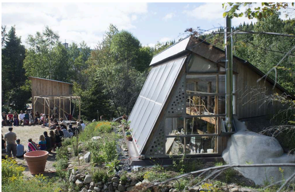
Figure 2. Serre solaire passive au Québec, vue de côté.
