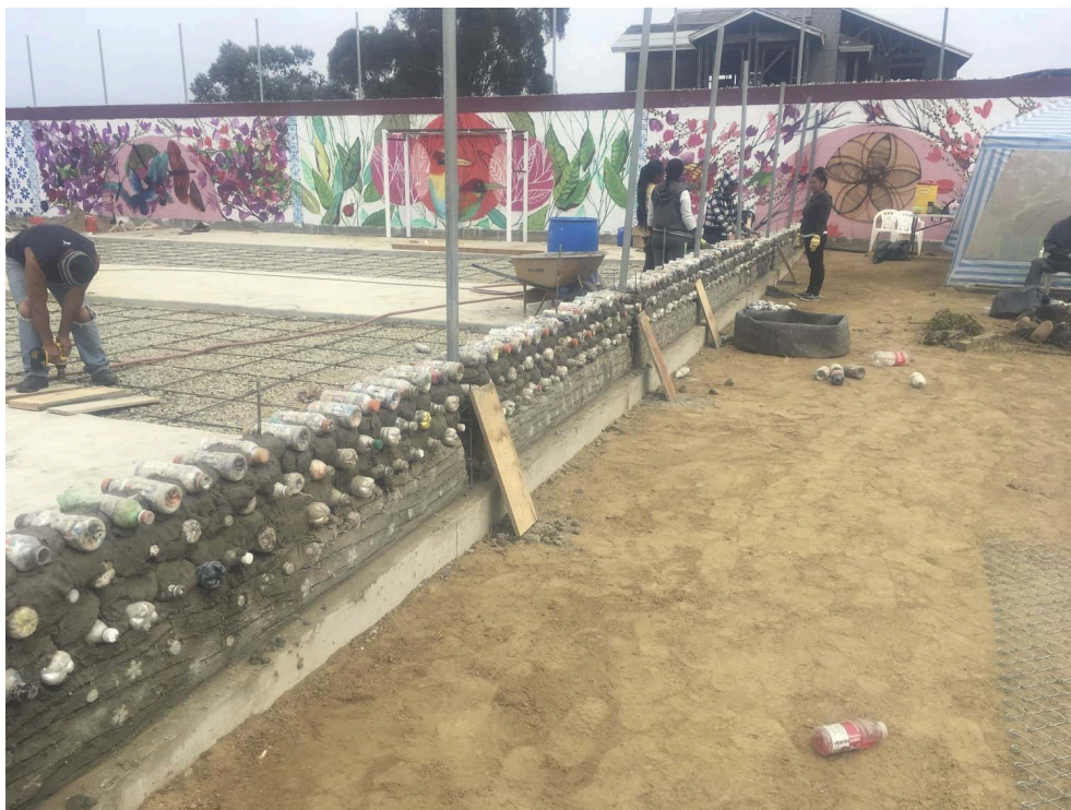
Figure 7. Mur en construction avec bouteilles de plastique remplies de déchets locaux collectés lors d'activités avec la communauté.
