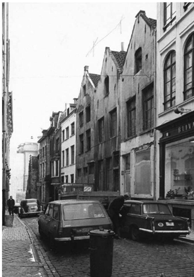
Figure 8 : La rue Sainte-Anne avant assainissement, Boîtes photos, A10-7-758, ARML.
