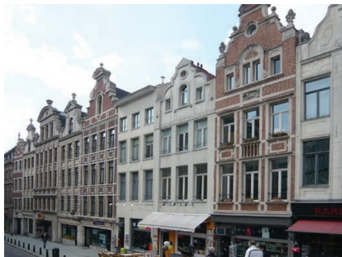
Figure 3 : La rue de la Montagne est une excellente illustration de l'application des prescriptions esthétiques du plan particulier de l'« Îlot sacré » : les façades sont durement restaurées et souvent, reconstruites, aux fins d'obtenir une image cohérente de la rue, juin 2012, cliché CH.
