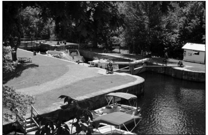
Illustration 1 : Écluses de Jones Falls, canal Rideau, Ontario. Photo : Marie-Blanche Fourcade.
