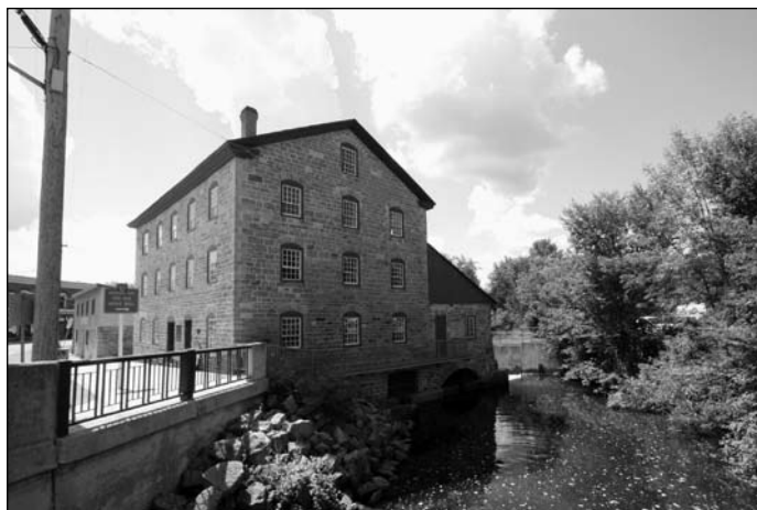
Illustration 2 : Lieu historique national Old Stone Bridge, Delta, Ontario. Photo : Martin Drouin.
