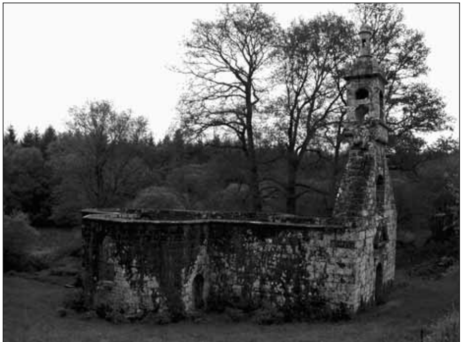
Construite au 17 e siècle à flanc de coteau dans la vallée du Naie au cœur du Morbihan, la petite chapelle de la Trinité de Lanvégen a bénéficié de l'appui de différentes associations de sauvegarde depuis un demi-siècle.
