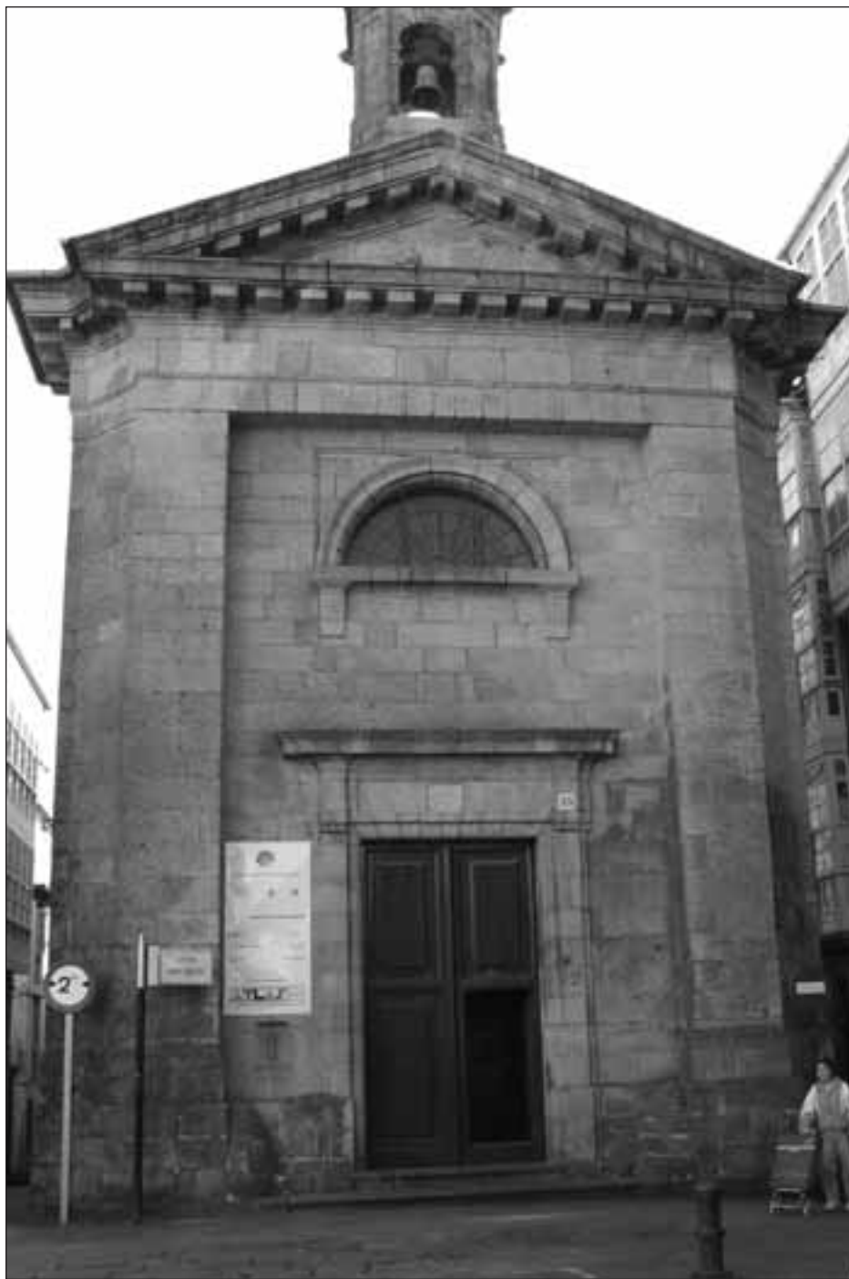
San Benito, en cours de réhabilitation.
