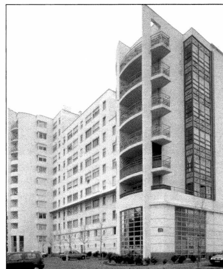
Quai de Rohan, opération de réhabilitation d'un grand ensemble de logements. L'immeuble a été coupé en deux parties pour laisser place à une rue, et sa façade a reçu de nouveaux éléments de confort (balcons, bow-windows, etc.).
