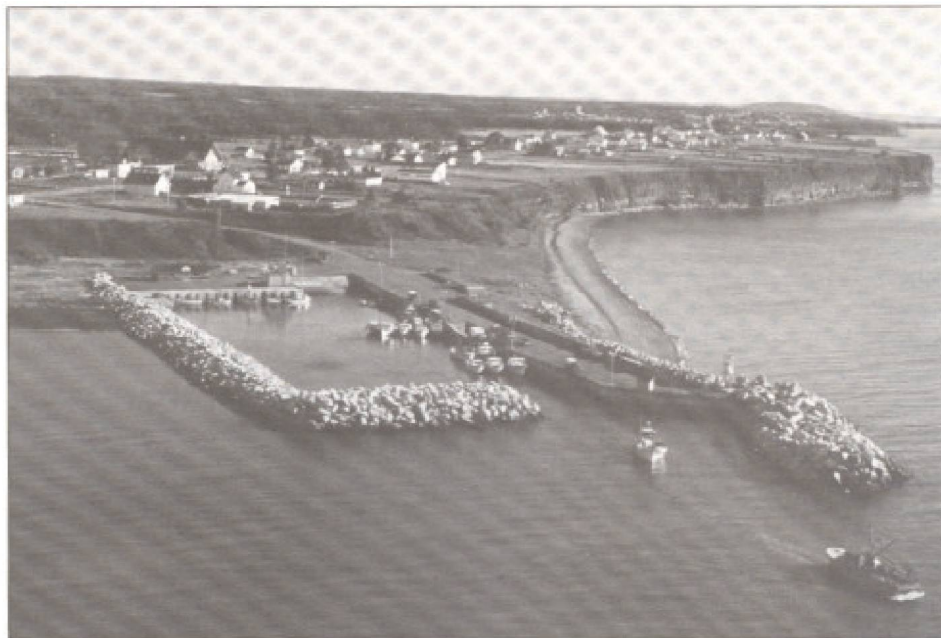
Le port de pêche de Saint-Godefroi. Une remarquable infrastructure portuaire doublée d'une plage et d'une falaise roses qui sont largement sous-utilisées au plan récréotouristique. Photo : Eugen Kedl.
