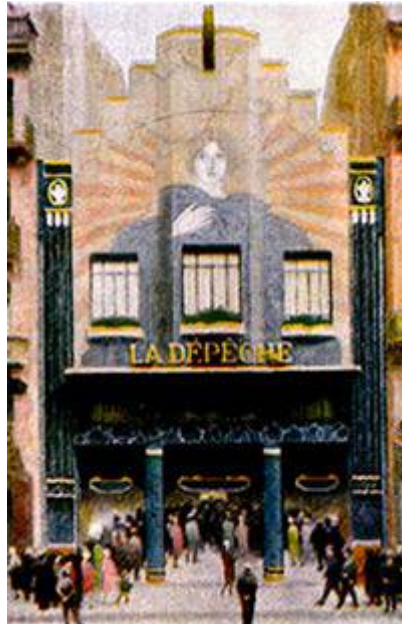
Façade de l'édifice du journal La Dépêche
