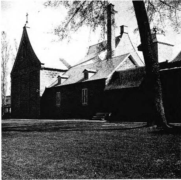
FIGURE 11. Caughnawaga. Vue du chevet de l'église Saint-François-Xavier, construite en 1845, d'après les plans du père Martin, élaborés en collaboration avec l'abbé Marcoux (Photo: Inventaire des biens culturels).
