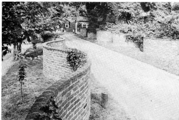
FIGURE 13. Détail d'un mur de forme serpentine.
