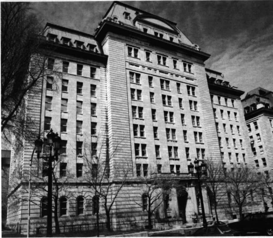
Figure 10 Édifice André-Laurendeau construit entre 1934 et 1937, rez-de-chaussée en granite de Saint-Sébastien, colonnes en granite Gris de Stanstead, étages en calcaire de la Formation de Deschambault de Saint-Marc-des-Carières.
