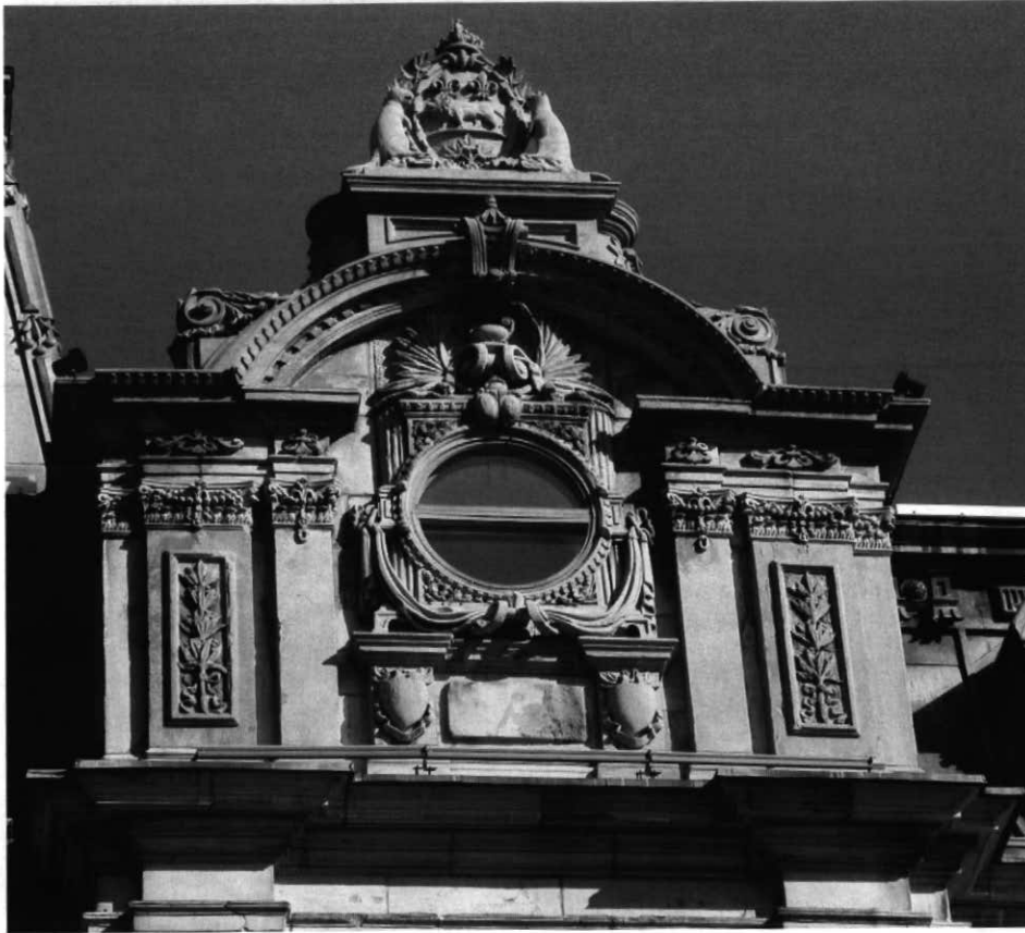
Figure 13 Sommet d'un pavillon d'angle de l'Aile de la Grande Allée orné de fines sculptures sur calcaire de Saint-Marc-des-Carières, coiffé d'un écusson des armoiries du Québec supporté par deux castors dressés.
