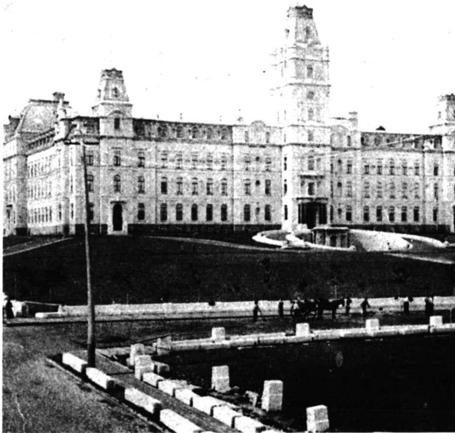
Figure 5 Photo de l'Hôtel du Parlement en 1889 montrant la façade du Palais législatif et la Tour Jacques-Cartier, et les travaux d'aménagement du parterre et du muret d'enceinte en granite Gris de Stanstead. (Source : Archives publiques du Canada).
