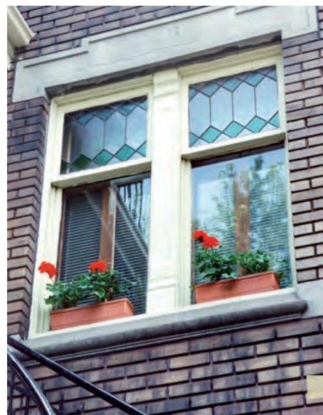
Exemple d'une fenêtre à guillotine dont le châssis supérieur est orné d'un vitrail.
