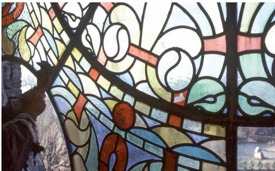
Un artisan procède à la dépose d'un vitrail installé dans une rosace. Une opération qui demande beaucoup de doigté !
