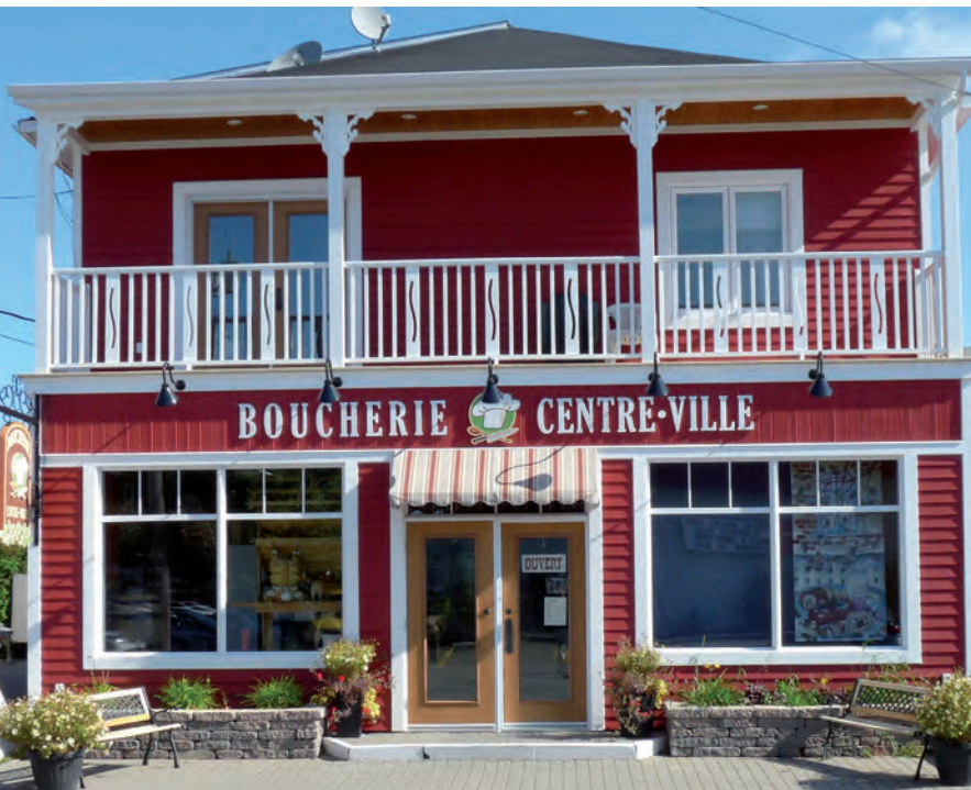
À Trois-Pistoles, des bâtiments situés au cœur de la municipalité ont été restaurés au cours des dernières années, notamment la Boucherie Centre-Ville.
