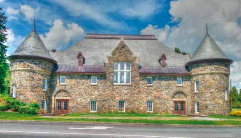
La Maison de la culture Francis-Brissson a été inaugurée en 2012 dans un ancien club social de la papetière Laurentide signé David Jerome Spence.
