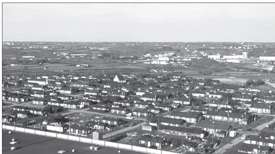
Figure 12 Barraques de logement pendant la reconstruction de Brest, quartier du Polygone, au lendemain de la Deuxième Guerre mondiale
