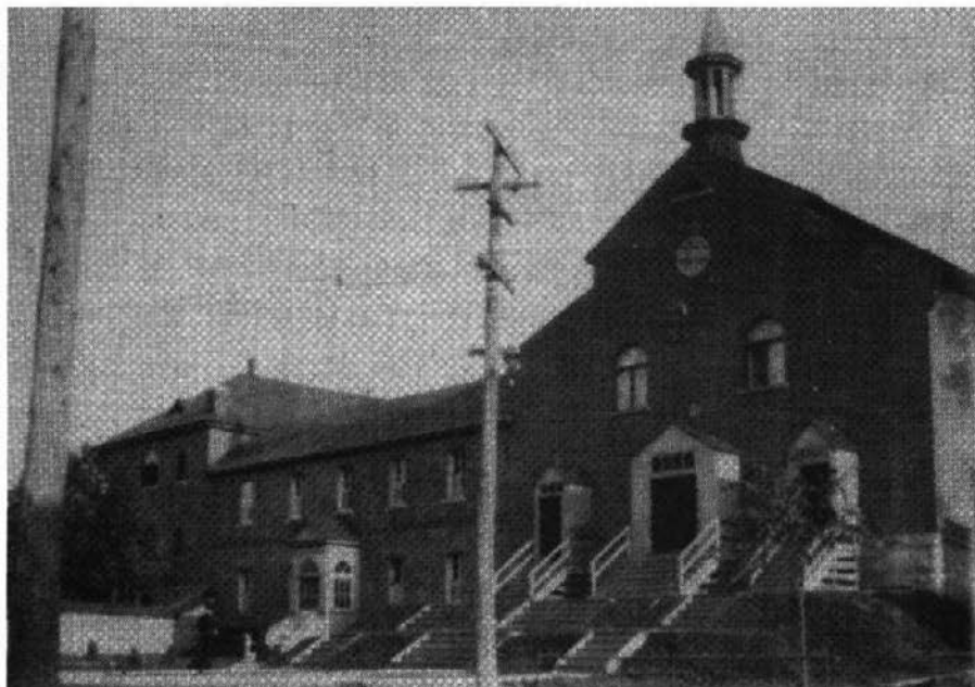
Premier couvent des capucins à Ottawa, construit en 1890-1891.
